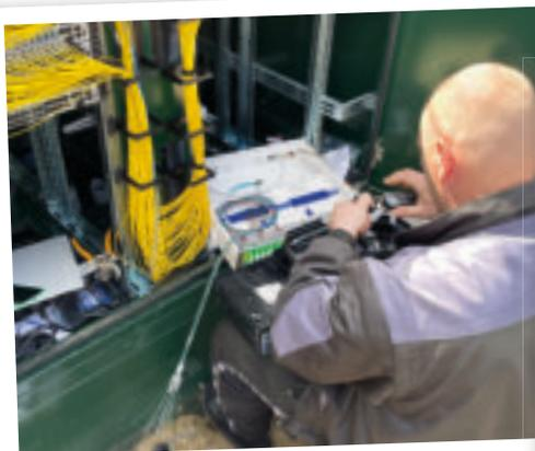
*Aufschaltung des Glasfasers für den späteren Anschluss der Haushalte.*
